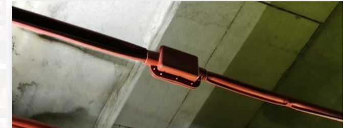
SPSM. Uso en Suspensión de Ménsulas. Montaje de conjunto de forros modelos SPSM-SWP12-SWP28 .
