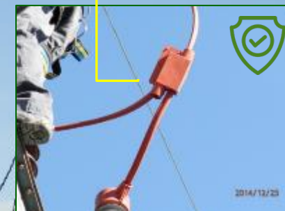
Mod. SAP : Protector para AMPACT-GRIMPI. Facilidad de adaptación en obra para uso en Bypass – derivación. Utilización en conjunto con Mod. SWP.
