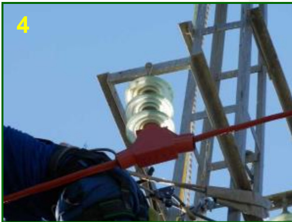
Imagen 2 : Facilidad de corte , instalación y cierre del protector Mod. SWP-12 incluso a bajas temperaturas.
