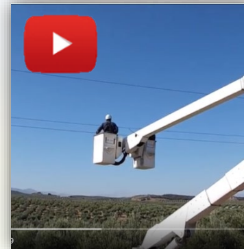
Instalaciones en Sur de España – 2017-2020 _ Red 15/36kV. Distancia total de separación entre fases 1,5m. – 2,8m.
