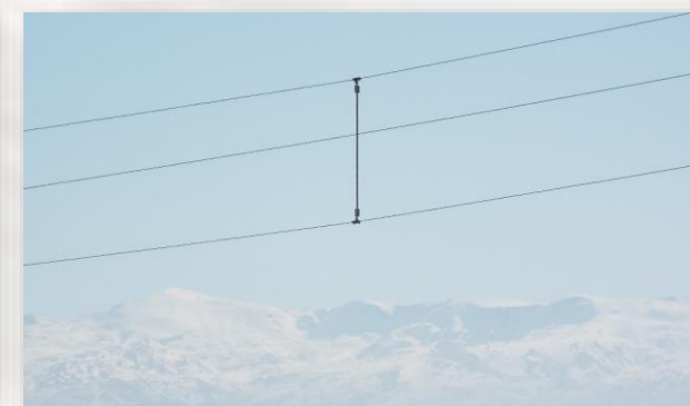
Instalaciones en Sur de España – 2017-2020 _ Red 15/36kV. Distancia total de separación entre fases 1,5m. – 2,8m.
