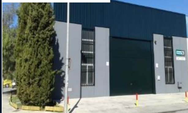
OFICINA Y ALMACÉN 01
