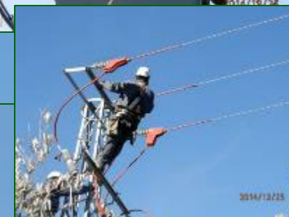
Instalación de los diferentes Dispositivos de Silicona CAON-KORWI sin herramientas. Fácil adaptación sobre el Apoyo.
