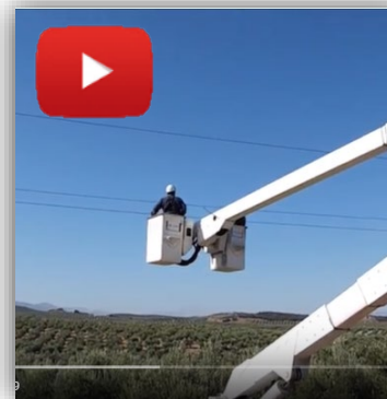
Instalaciones en Sur de España – 2017-2020 _ Red 15/36kV. Distancia total de separación entre fases 1,5m. – 2,8m.
