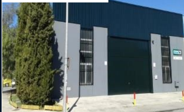
OFICINA Y ALMACÉN 01
